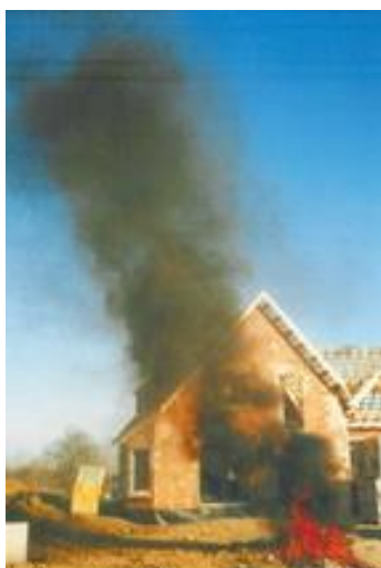
Brûlage de matières plastiques propre à polluer l'atmosphère.
